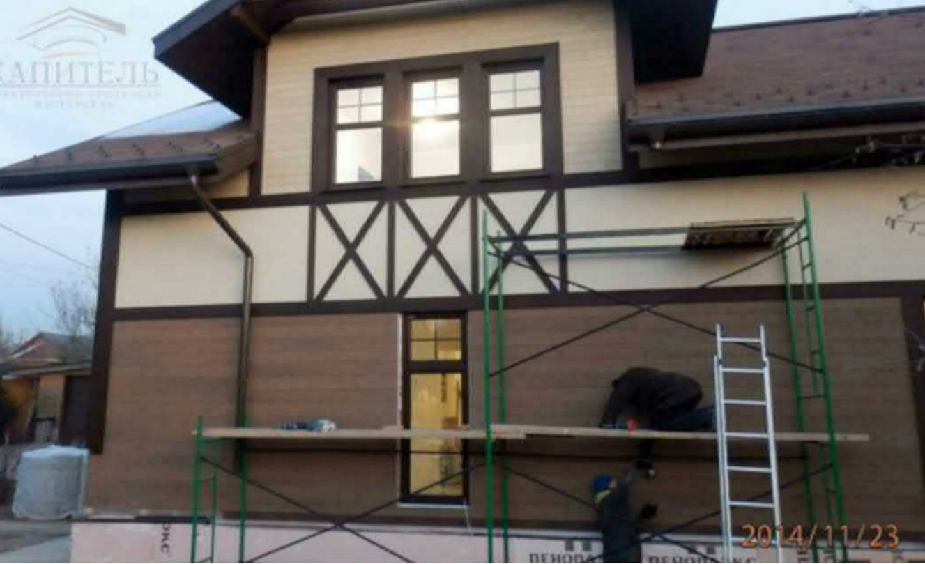
Каркасный дом в п.Сенькино-Секерино, Московской области этап работы-облицовка фиброцементными панелями Nichiha производства Японии
